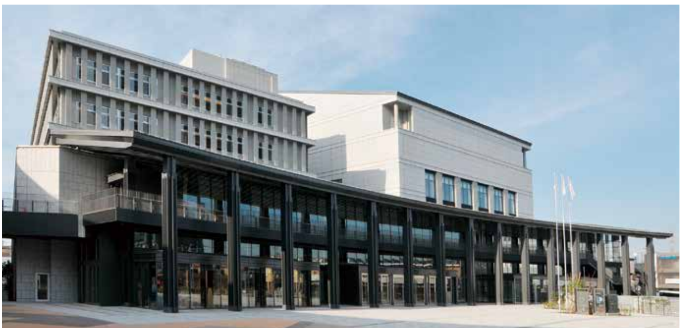
「ウエスト川越公共施設」外観
